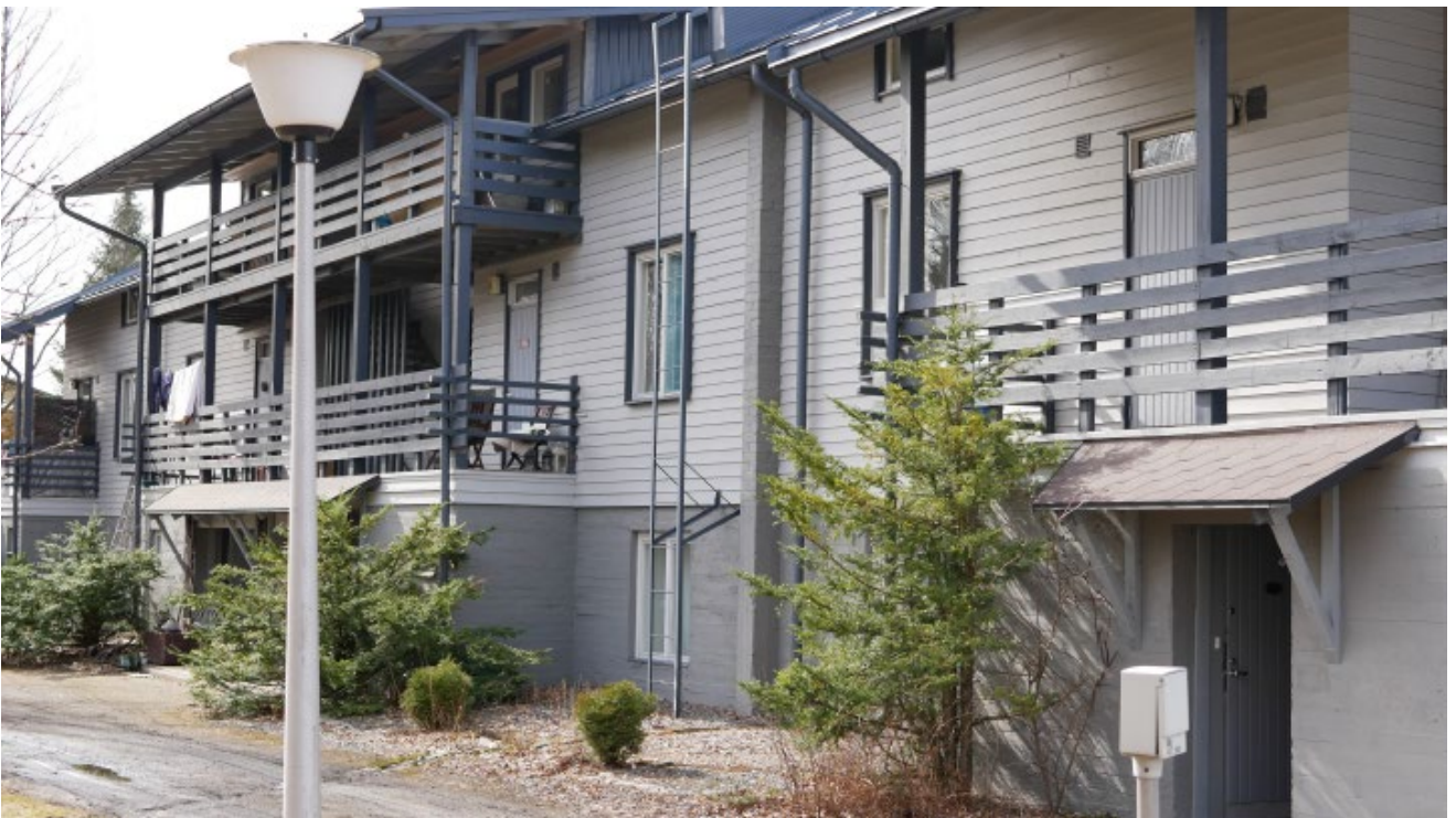
Pajakadun julkisivua pihan puolelta.
