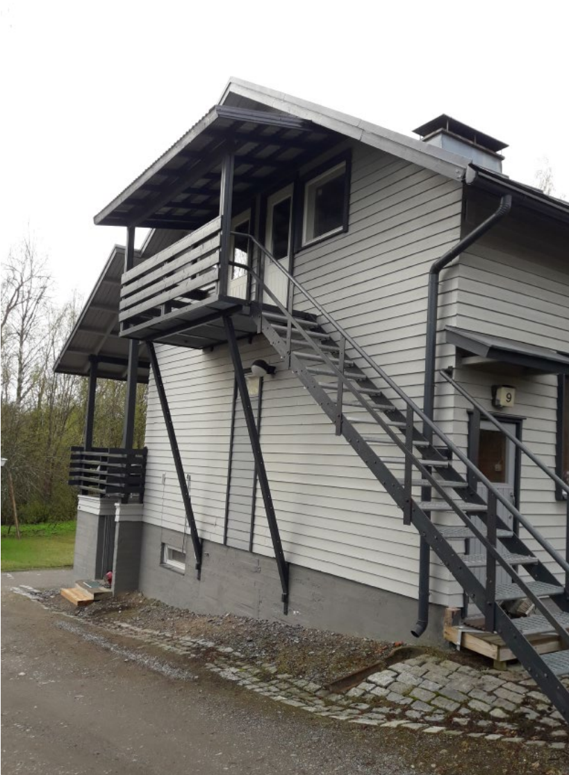
Molempiin pätyihin on rakennettu sisäänkäynnit.
