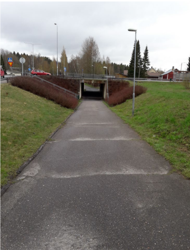
Juvantien alikulku, kuvattuna Peitsarinkujalta.
